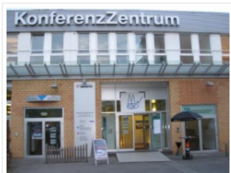
Eingang Gebäuderückseite – ACC-Seminarräume
